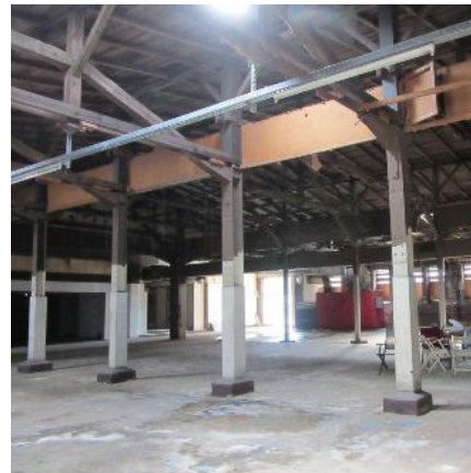
*Abb. 15 - Bestand Mantelhalle
