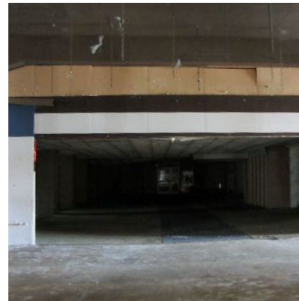
*Abb. 16 - Übergang Mantelhalle EG Werksgebäude 3
